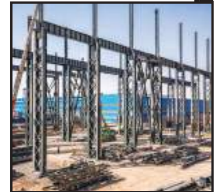
اسکلت فلزی کارخانه ذوب مجتمع تولیدی فولاد سپید فراب کویر
