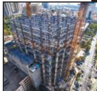
اسکلت فلزی پروژه هتل بین‌المللی ملل
